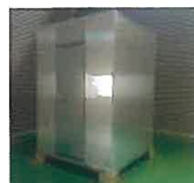
扉・屋根取付
